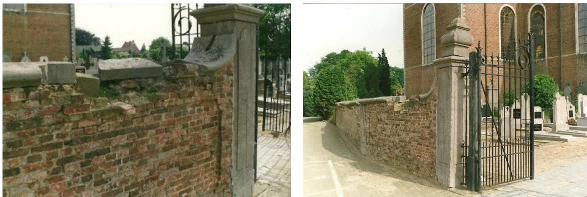
Afb.20. De toestand van de 18 de -eeuwse omheiningsmuur met verdiepte spiegels – Bron: Heemkring Meerhout, foto hkmp_03221 en 03222.
