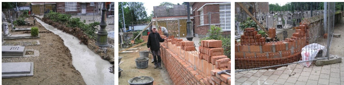
Afb. 21. Heropbouw van de omheiningsmuur – Bron: Heemkring Meerhout, foto hkmp_17243, 17244 en 17249.
