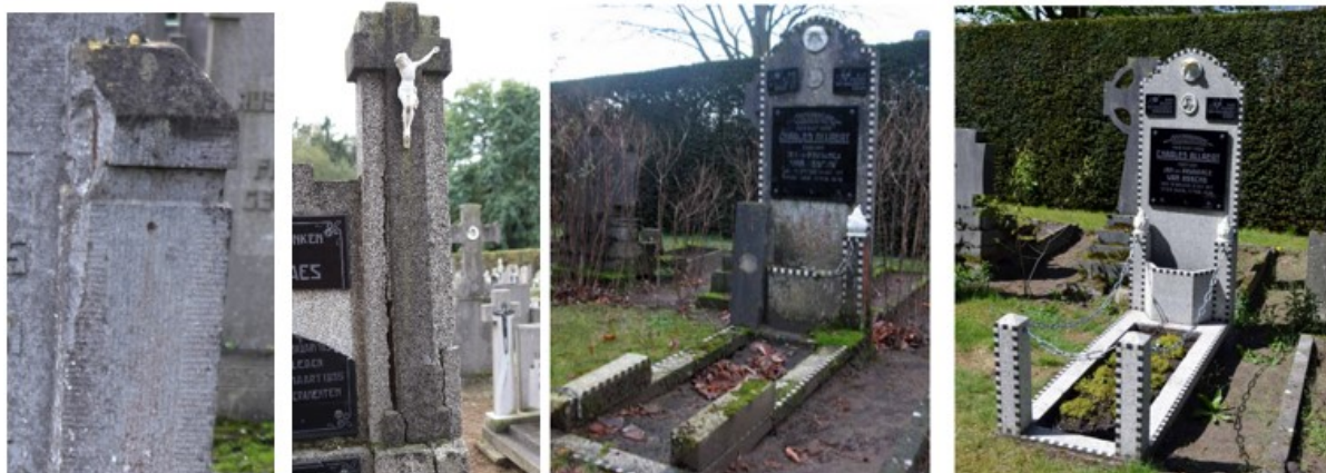
Graftekens met betonrot (2_H_13 en 3_H_5.)
