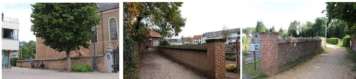
Afb. 22. De omheiningsmuur in 2021: ten noorden van de toegangspoort en aan de westzijde waar ze deels vernieuwd is en deels nog oorspronkelijk is (1892).
