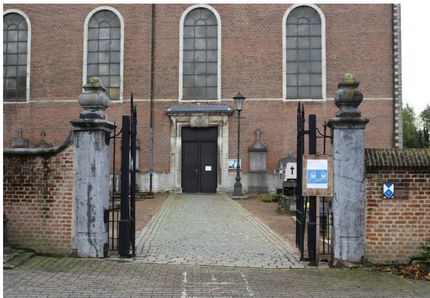
Afb. 3. De 18 de -eeuwse hekpijlers en aanpalende kerkhofmuren na restauratie in 2011. De ijzeren poort dateert van 1900.
